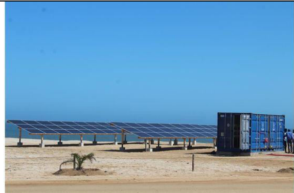
Die Seewasser-Entsalzungsanlage ist weltweit die erste derartige Anlage, die von erneuerbarer Energie, in diesem Fall in Solarsystem, angetrieben wird. Foto Adolf Kaure
