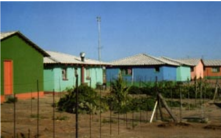
Lehmhäuser des Clay House Project in Namibia
