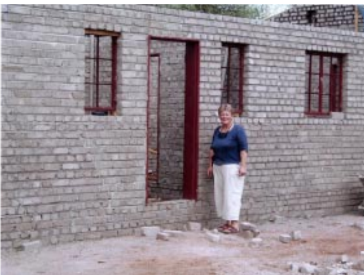
Krankenschwester Una Harrington vor dem Rohbau der Klinik in Otjikondo
